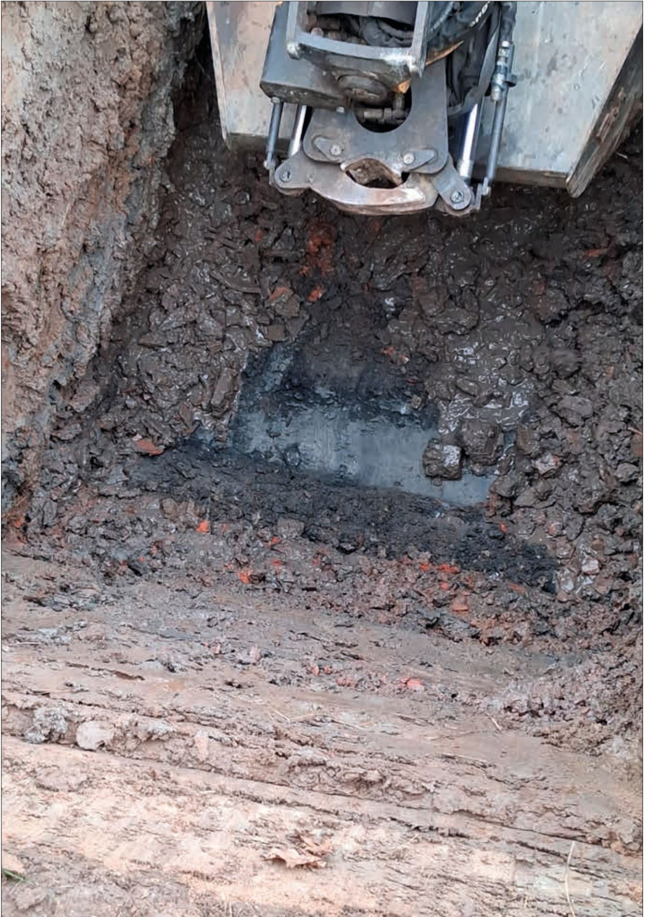
Figur 12. Det cirka 0,6 meter tjocka lagret med tegelkross grävs igenom med grävmaskin. Foto: Johannes Nieminen.
