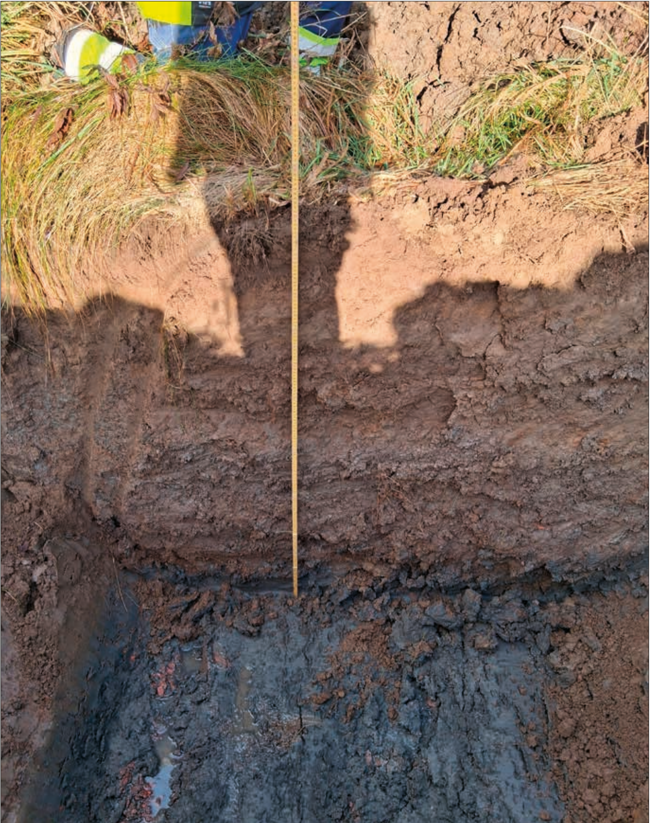
Figur 11. Bilden visar svämsediment som överlagrar ett lager med tegelkross i botten på schaktet (S1005).
