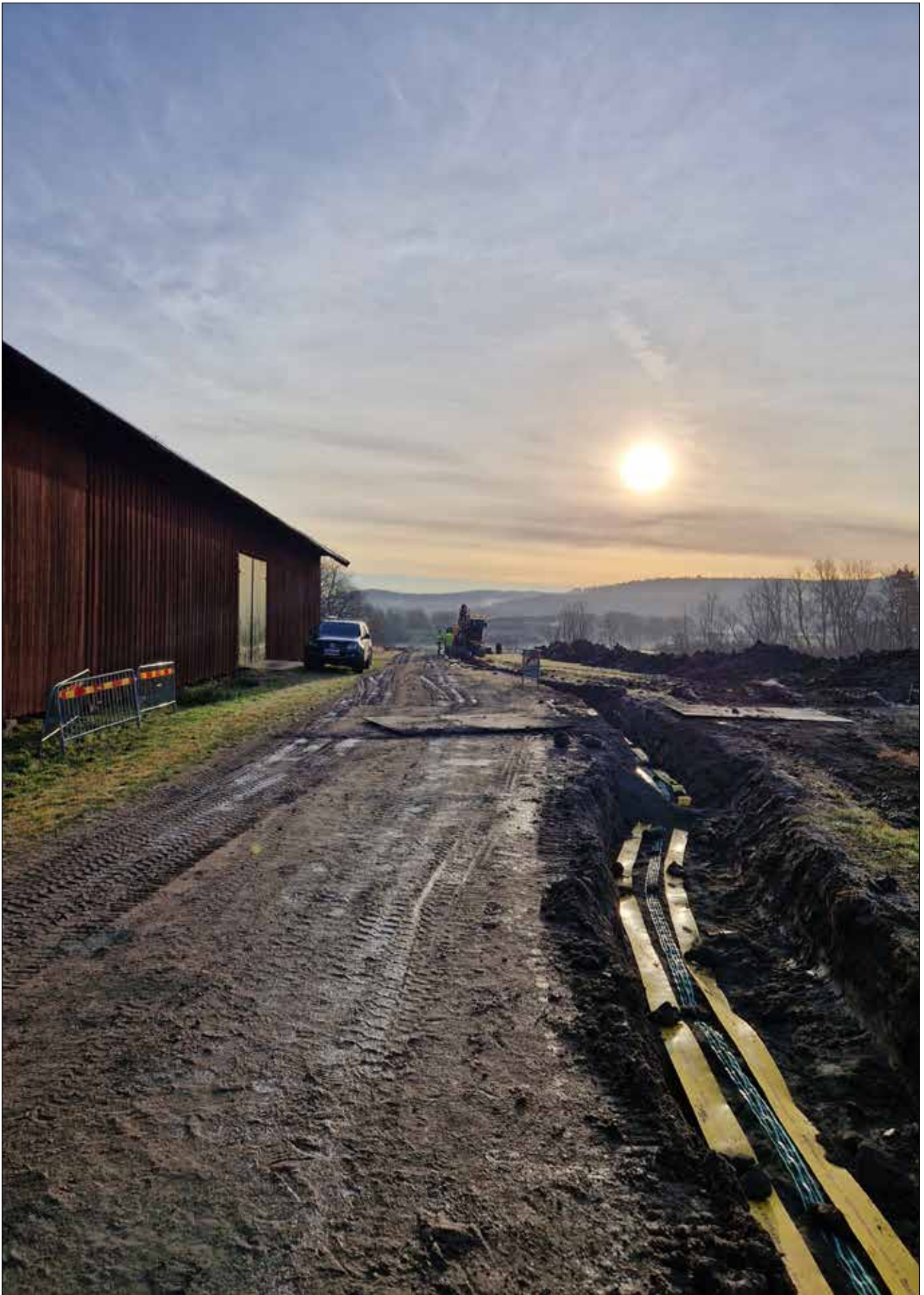
Figur 45. Ledningsnedläggning efter avslutad schaktning inom schakt 9028. Fotot är taget i riktning mot Nordre älv i den västra delen av undersökningsområdet. Foto mot öster.
