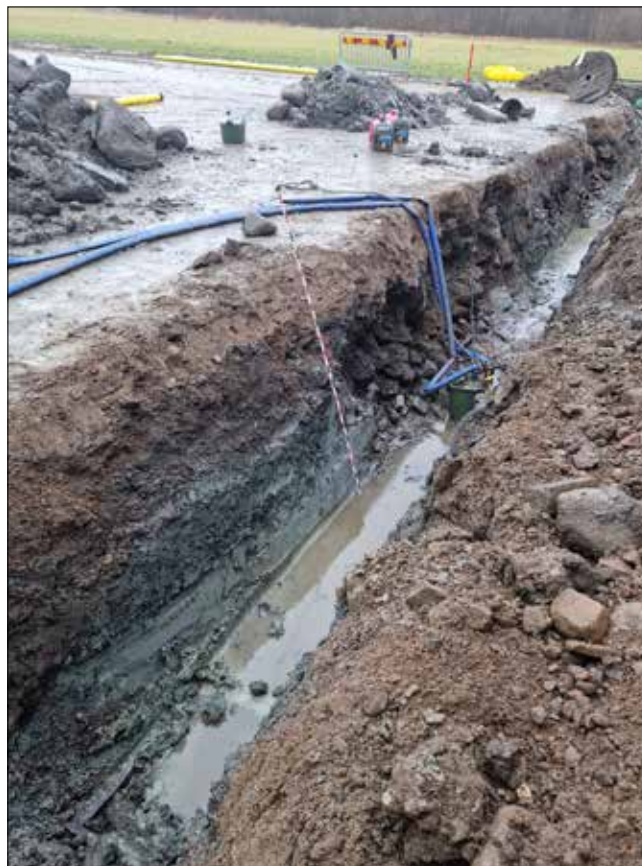
Figur 28. Inom stora delar av schakt 9033 dokumenterades ett lager (S2068) med nedgrävda stenar som sannolikt stört eventuella lämningar efter kyrkogården i denna del. Stenarna syns i vänstra schaktkanten på fotot. Foto mot nordväst.
