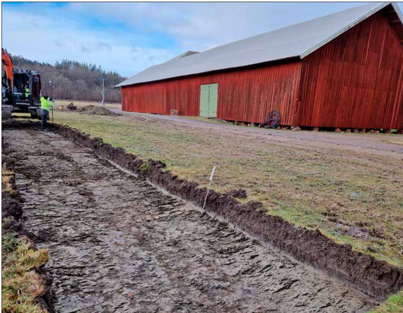
Figur 10. Ett långt schakt (schakt 9) grävdes i det flacka partiet utmed området närmast stadslagret. I detta område hittades de också de flesta fynden i samband med detekteringen. Inga anläggningar påträffades dock i schaktet. Foto taget mot norr.
