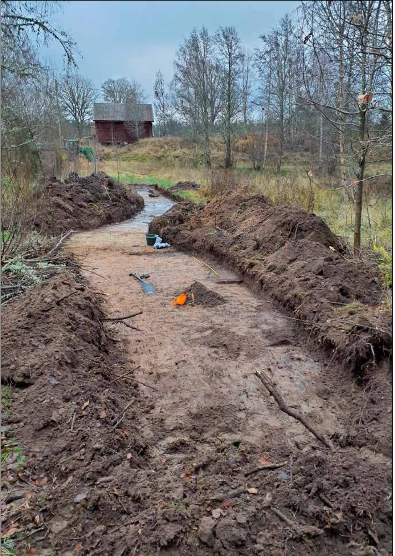
Figur 5. Västra delen av schakt 1. Foto mot SO.
