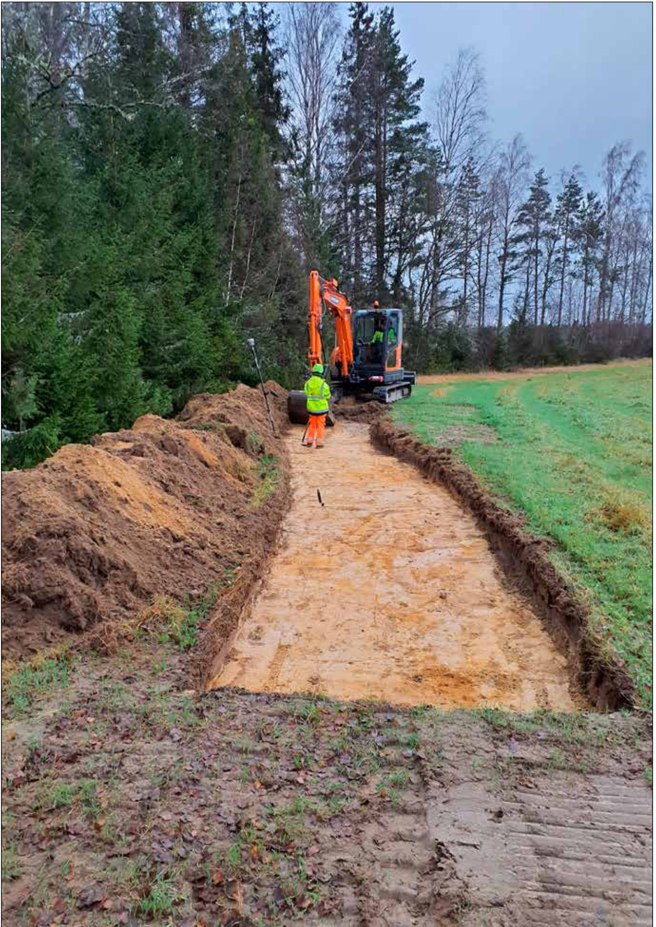
Figur 10. Schakt 2 där anläggningarna syns i förgrunden. Foto mot S.
