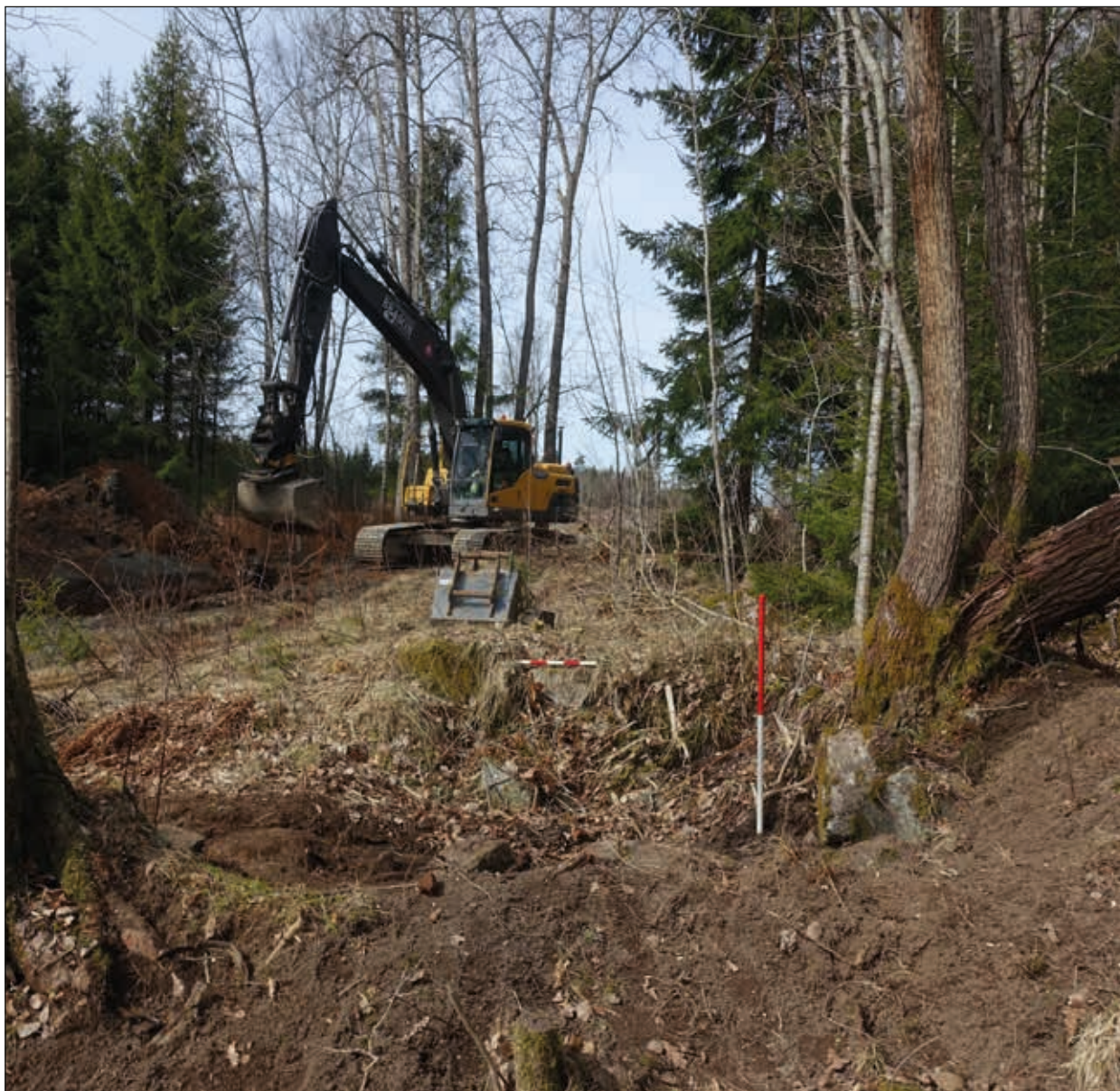
Figur 9 (t.v). Lämning 3, en jordkällare, innan undersökning inom Vänersborg 95:1. Foto mot väst.
