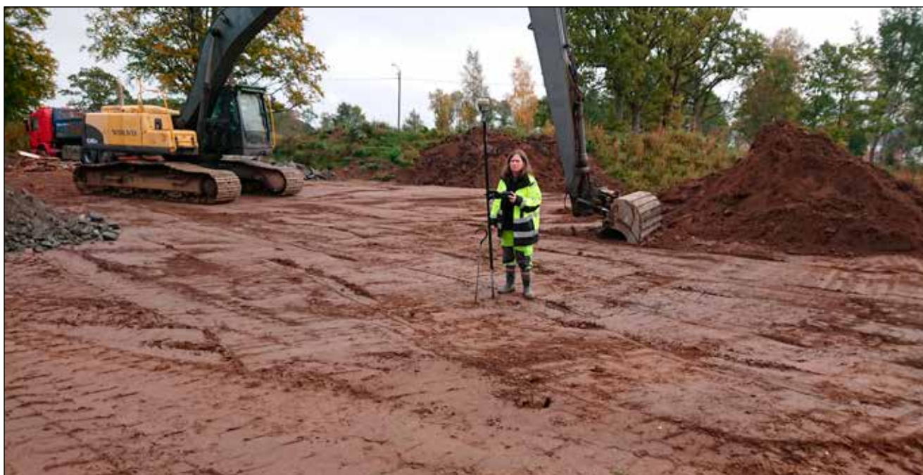
Figur 7 (nedan). Platsen för lämningen L1972:7228. Den berghäll på vilken de förmodade sentida skålgroparna funnits är idag bortspräng och ytan har fyllts ut med fyllnadsmassor inför kommande byggnation. Foto mot nordnordost.
