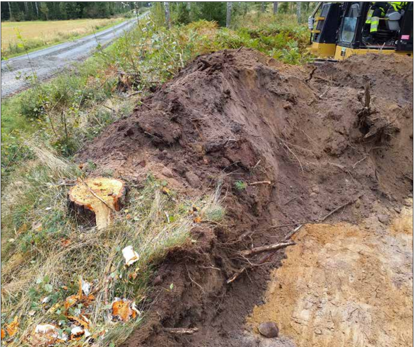
Figur 5. Påförd sand ligger som en vall vid ett grävt dike längs grusväg som går i nordostlig-sydvästlig riktning. Schakt 38. Foto mot söder.
