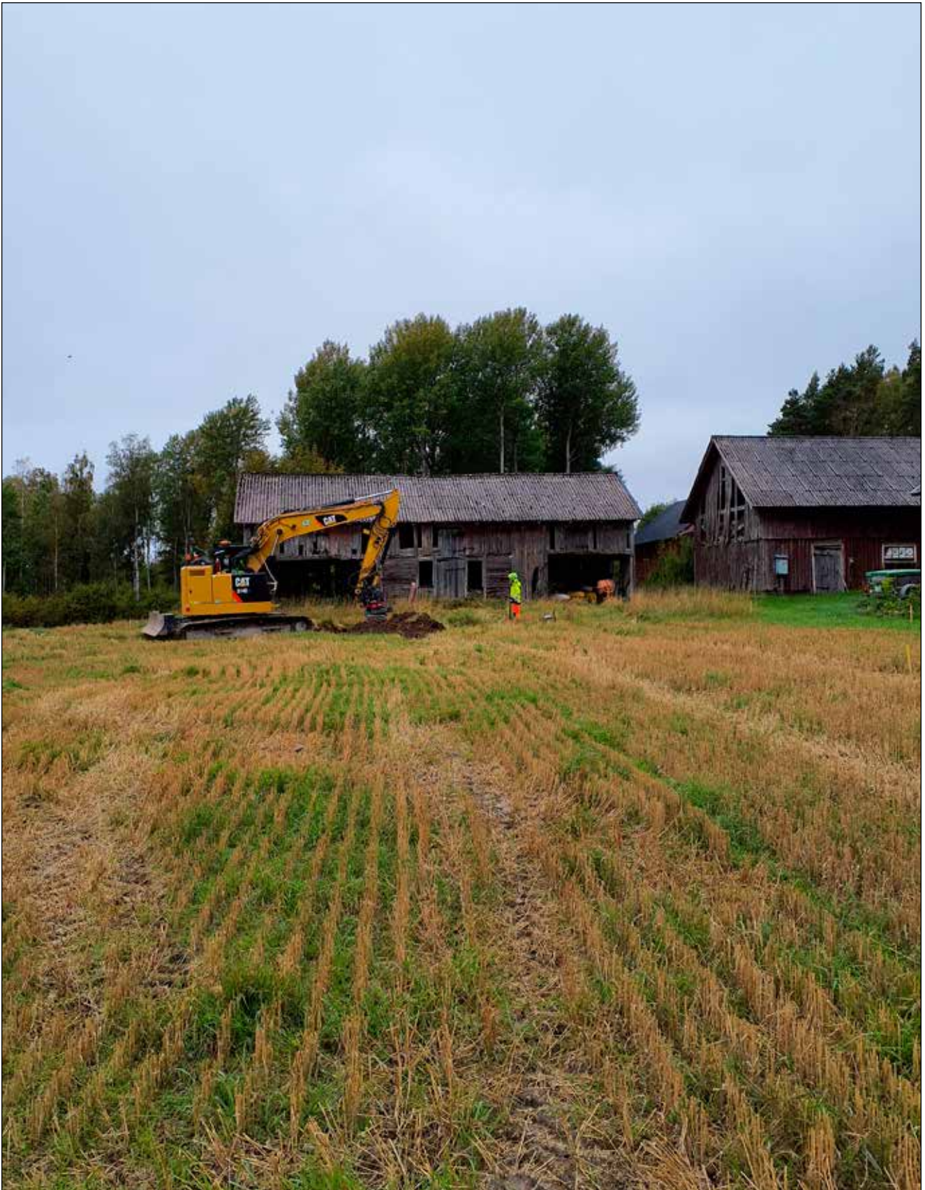
Figur 22. Maskinen schaktar vid gården i Däverud. Foto mot väster.
