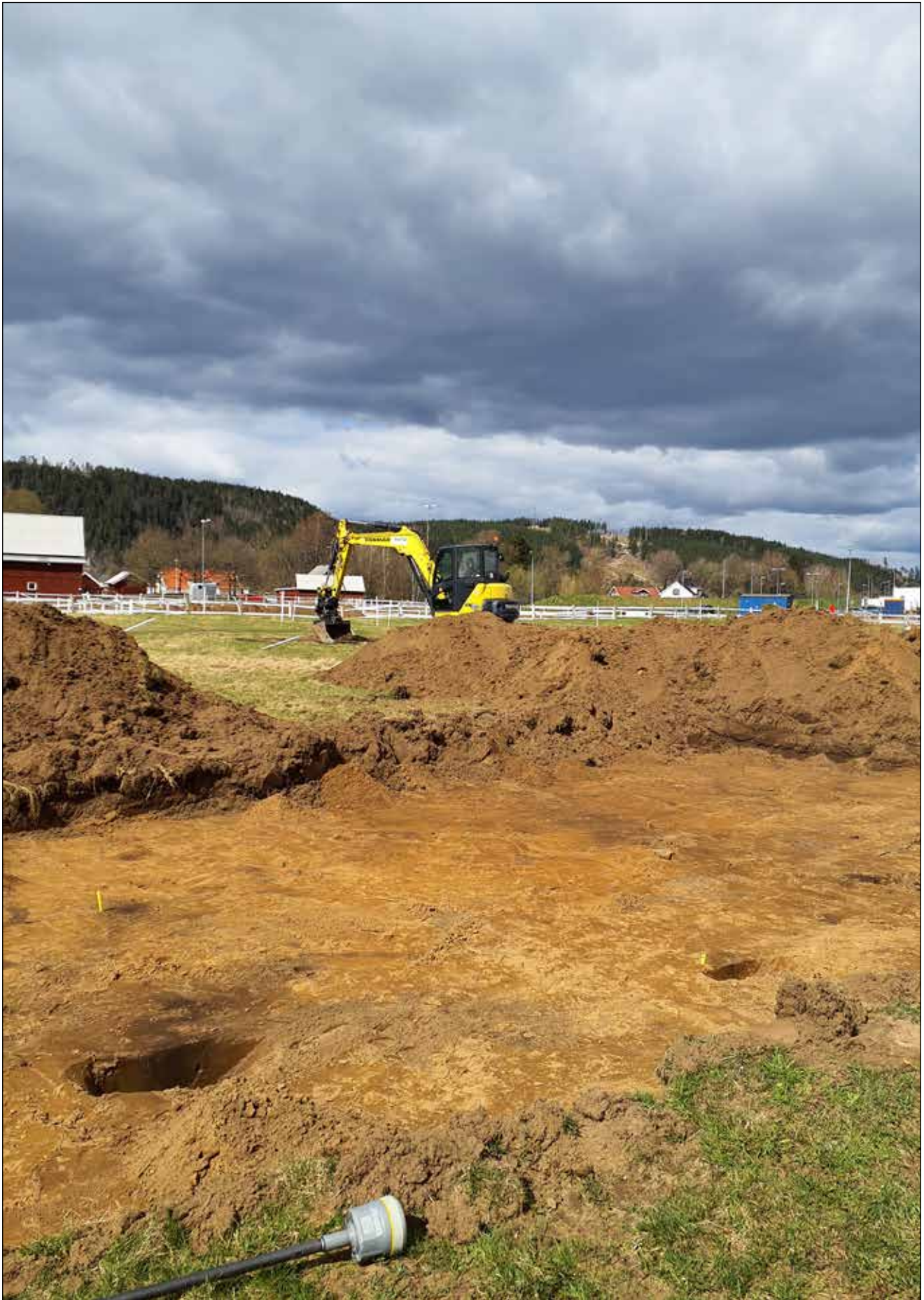
Figur 4. Arbetsbild med schakt 9 i förgrunden. Schaktet dokumenteras medan grävmaskinen lägger igen ett tidigare schakt. I bakgrunden syns Vistbergen. Foto mot NV.
