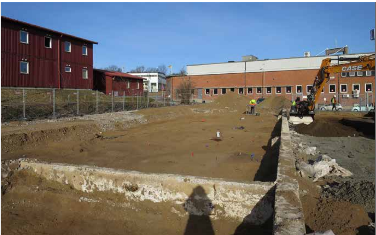
Figur 6. Den avbanade ytan inom undersökningsområdet. Foto mot nordväst.
