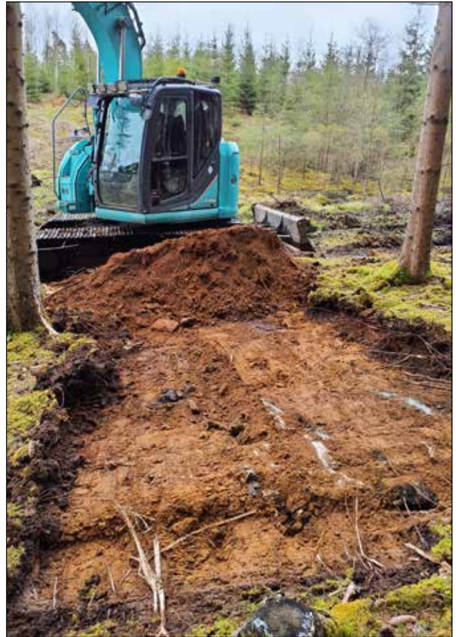
Figur 5. Schakt 52, som gräves i den uppvuxna skogen, är ett exempel på den tunna förnan och den efterföljande rödjorden i området. Foto mot SÖ.
