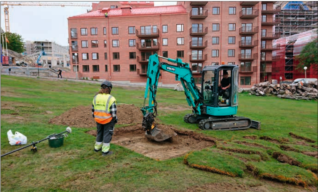
Figur 5. Schakt inom undersökningsområdet. Foto mot nordväst.
