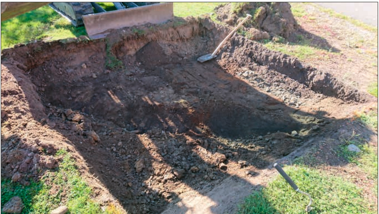
Figur 9. Den lerförstärkta grustäktskanten i S5. Foto mot sydväst.
