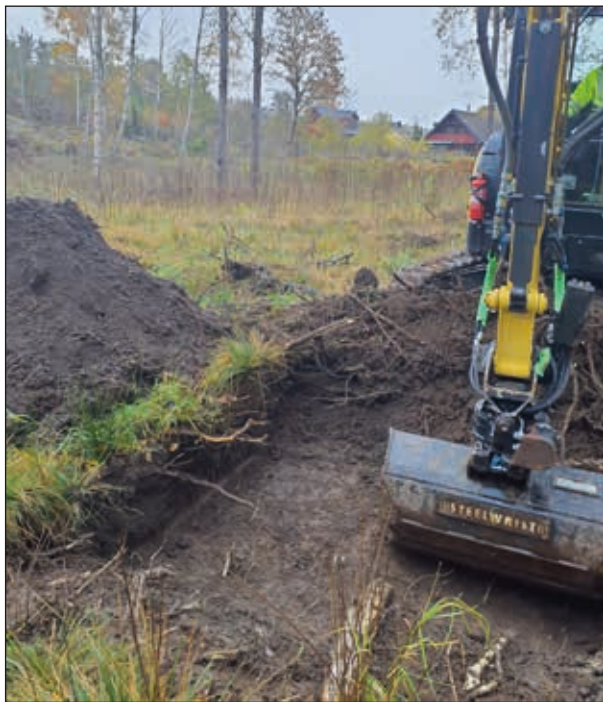
Figur 7. Arbetsbild från schakt 1003 som drogs i utredningsområdets östra del. I denna del av utredningsområdet bestod markstratigrafin av silt och lera under matjordslagret. I bakgrunden syns några av villorna på Jöråsvägen. Foto mot NO.
