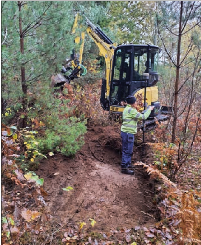
Figur 4. Arbetsbild från S1007 där Karin Olsson mäter in schaktet med GPS. Foto mot NO.
