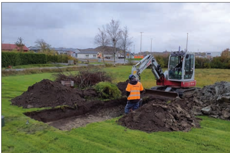
Figur 6. Den sydöstra delen av område 1 med schakt 1. Foto mot söder.
