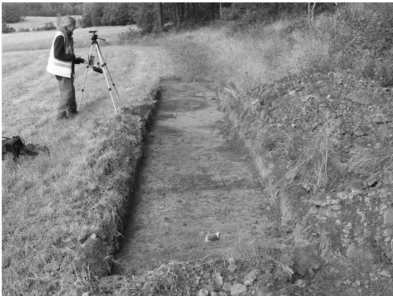
Ill. 8. Dokumentation av schakt 10 med anläggningarna 1 till 3. Foto mot nordväst.
