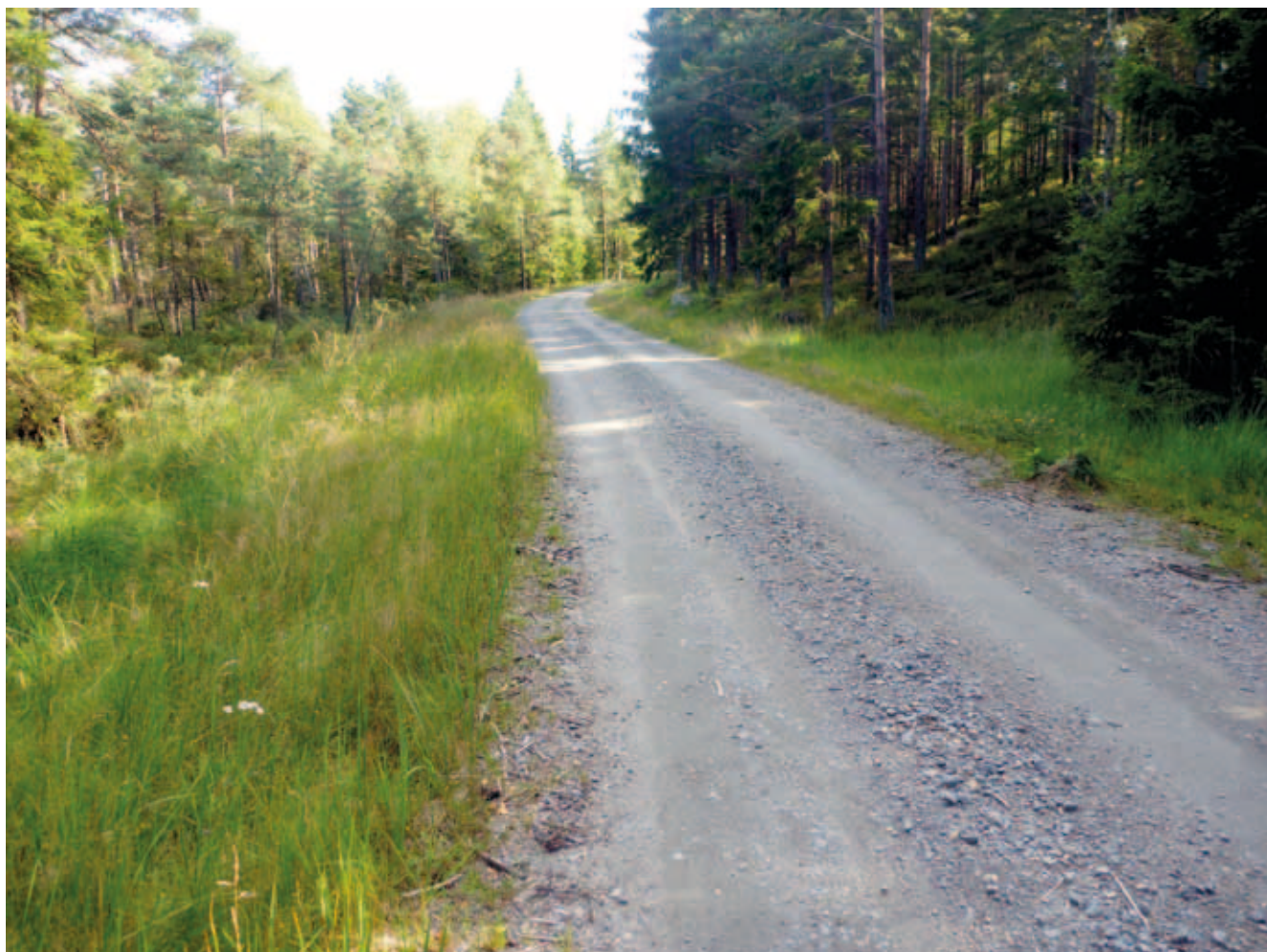
Illustration 4. Befintlig väg gränsar till Väre mosse, tallmosse till vänster i bild. Naturhänsynspunkt 10. Foto mot SSO.
