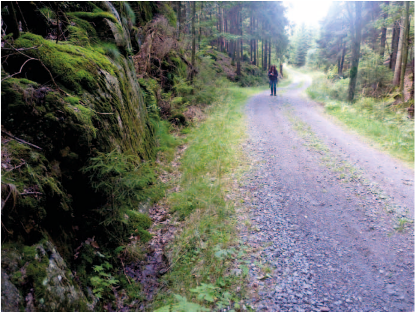
Illustration 5. Parti där väg behöver breddas vid hänsynspunkt 14 och 15. Berg avgränsar på bägge sidor om vägen. Bäckens rinner i diket till höger i bild. Foto mot SV.
