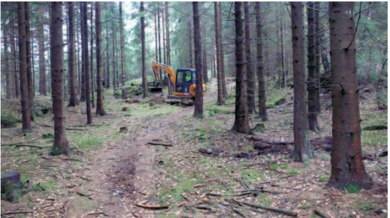
Illustration 5. Högås 142. Schakt 9 (igenlagt) till höger. Maskinisten är i färd med att ta upp schakt 10. Foto mot nordväst.
