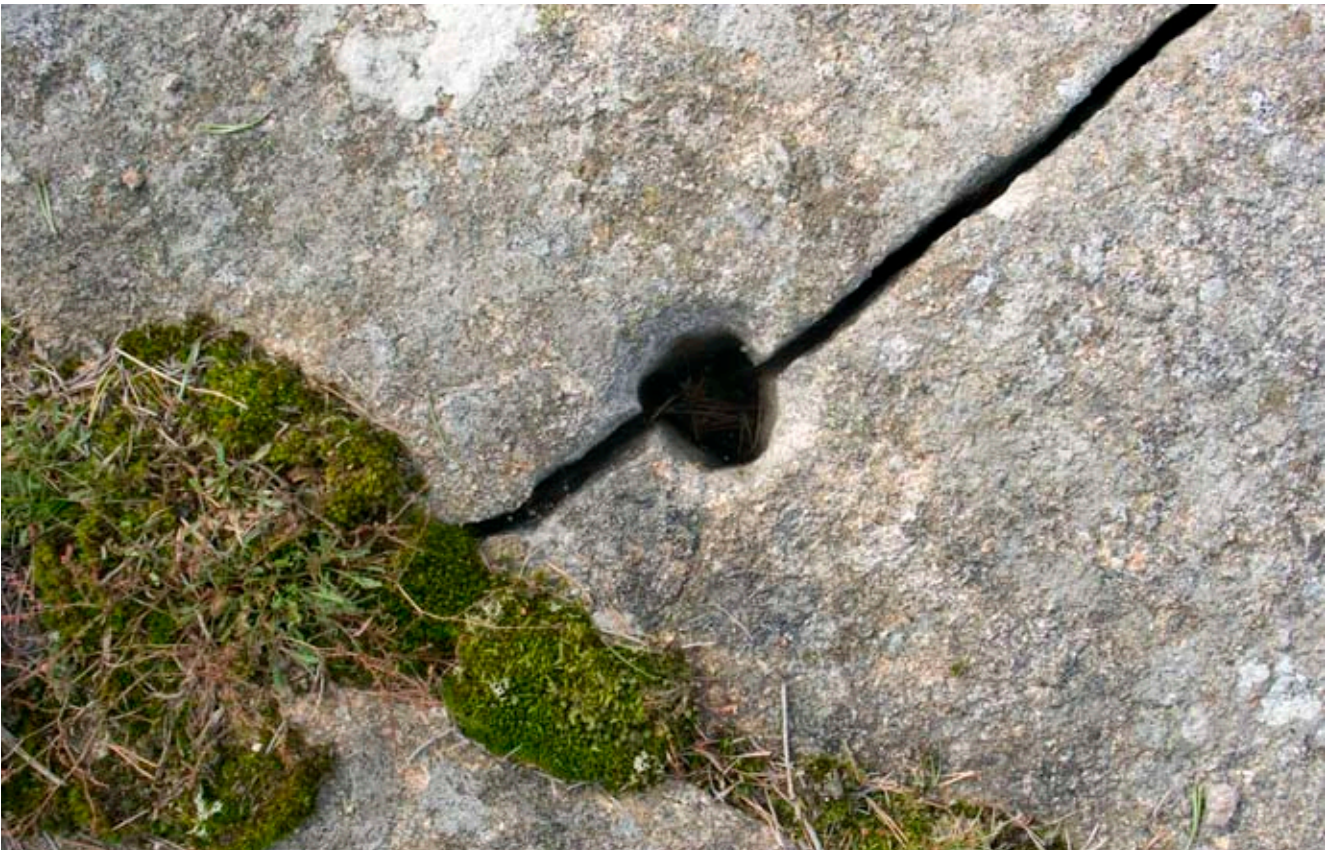
Ill. 11. Kranhål mellan brott 42 och 45. Foto mot söder.
