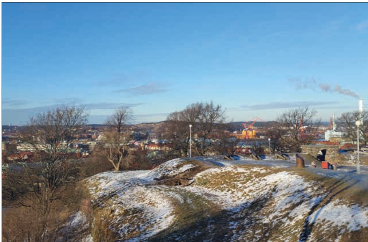
Figur 9. Foto över körväg för grävmaskin i den äldre störningen från 1996. Foto mot NV.
