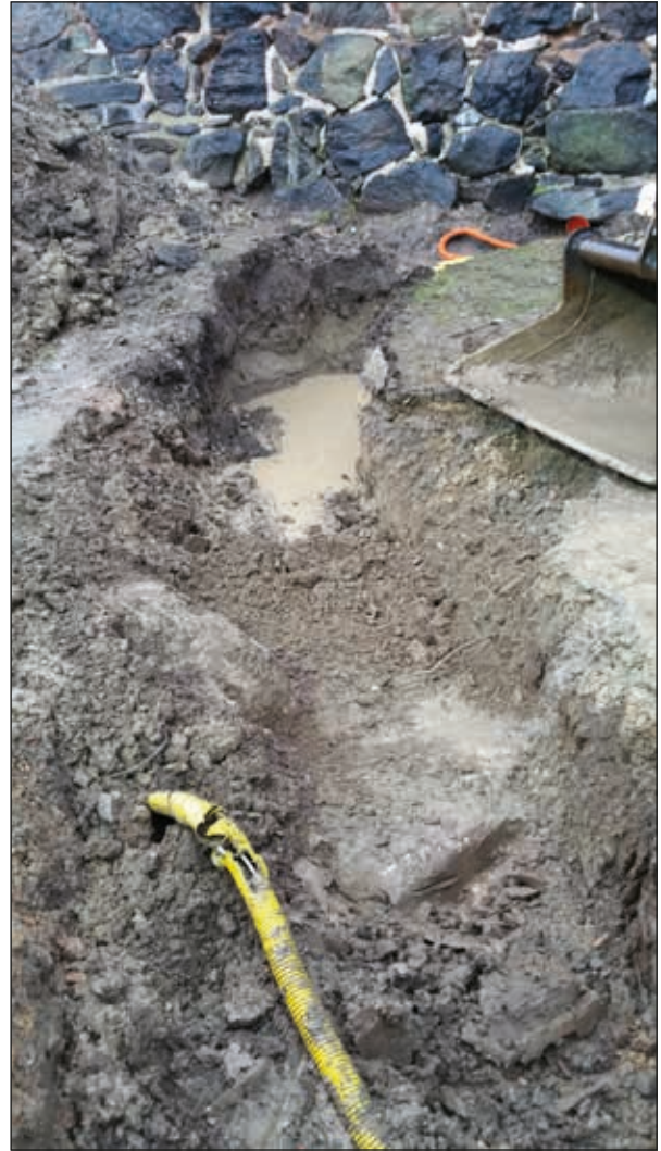
Figur 12. Foto av de stenar som möjligen kan de vara rester efter en äldre befästningskonstruktion. Foto mot NO.
