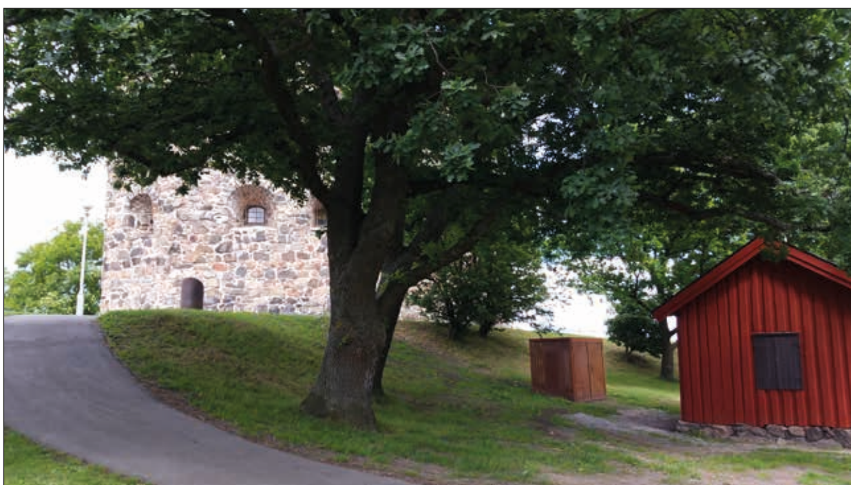
Figur 24 (nedan). Färdig värmeanläggning invid soldattorpet. Foto mot NO.
