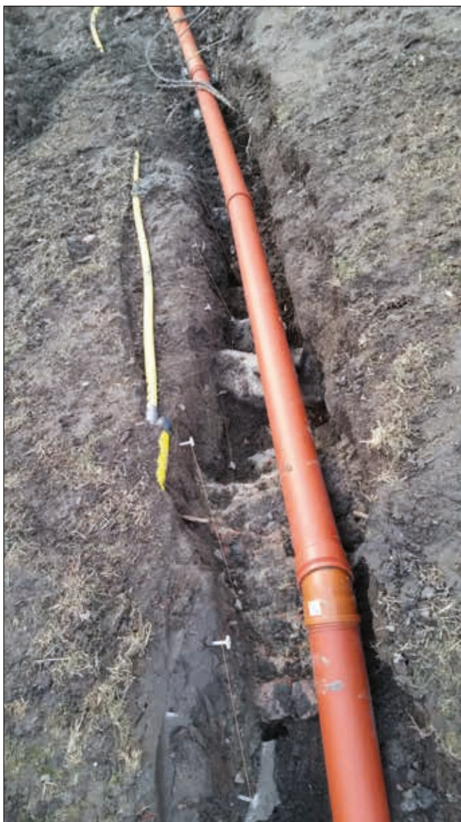
Figur 23 (t.v). Ledningsdragningen kunde genomföras utan att påverka fornlämningen. Rör för ledning anlades direkt på de dokumenterade återfunna befästningslämningarna. Foto mot S.
